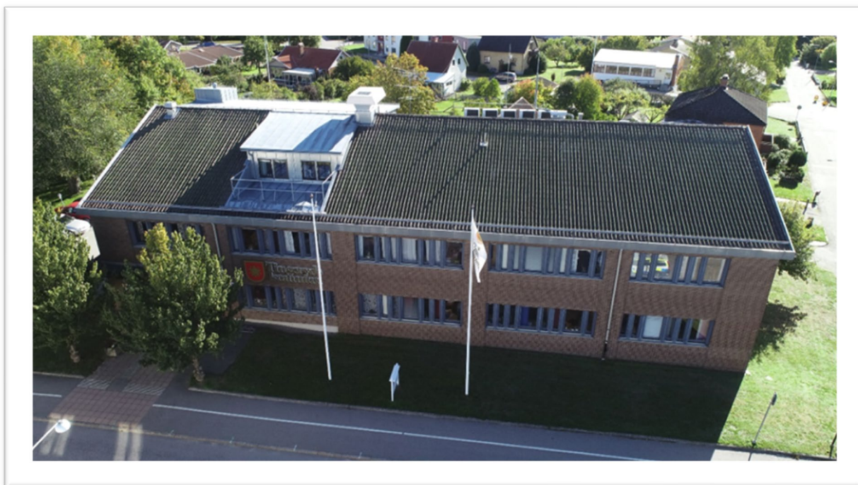
Kommunhuset i Tingsryd.
