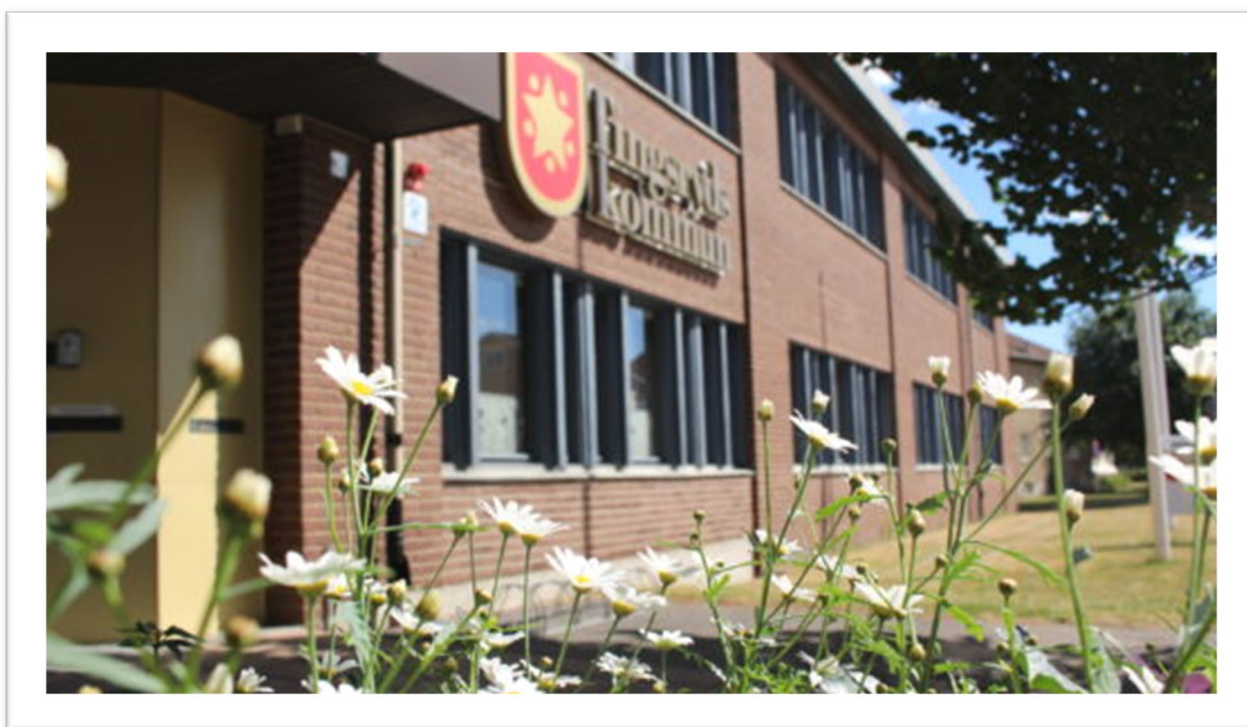
Kommunhuset i Tingsryd.
