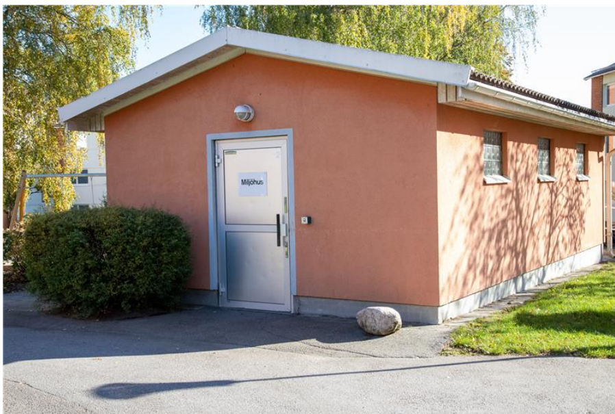
Figur 2 Avfallsrum med ljusinsläpp.
