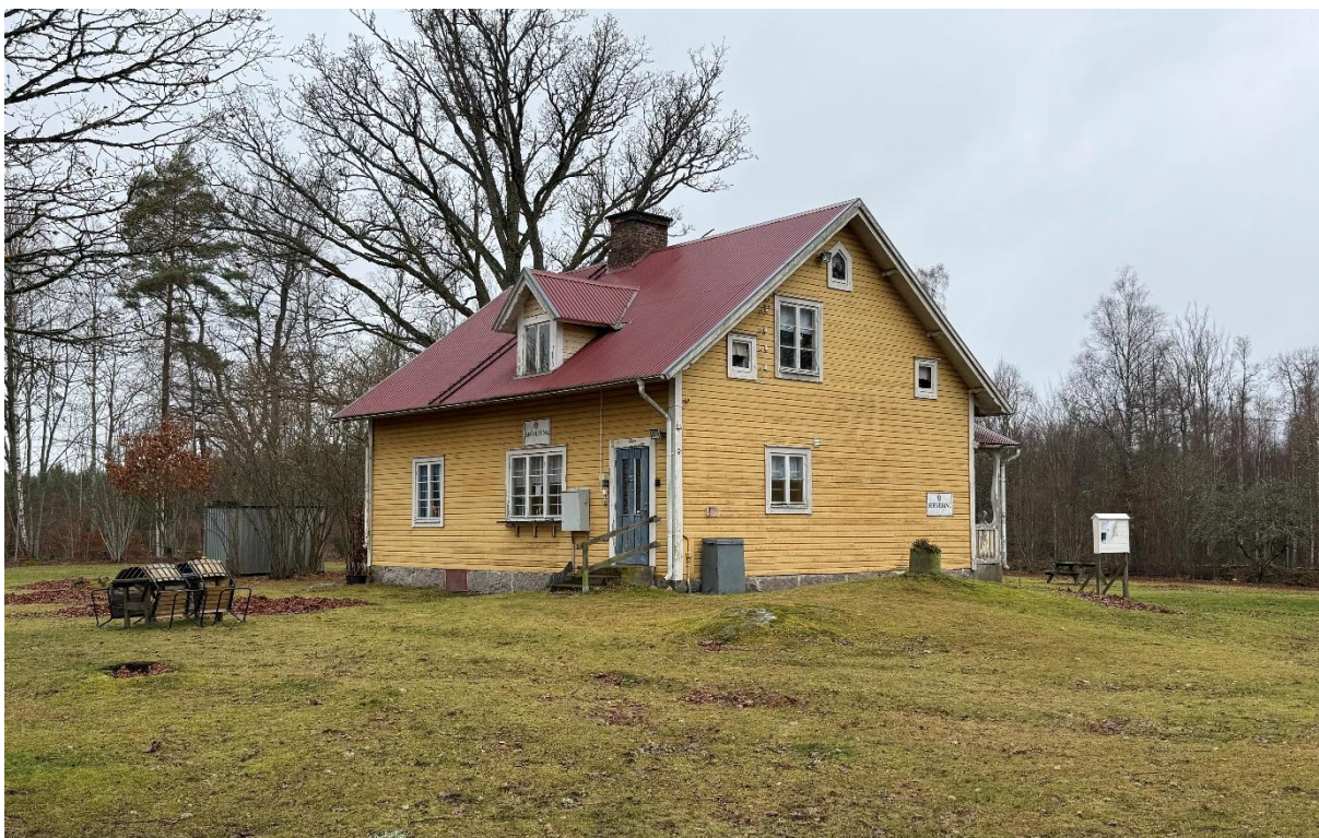
Byggnaden i vy mot nordväst. Foto: Ludwig Svensén, 2025
