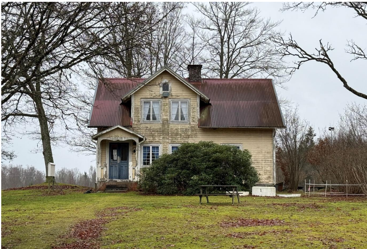
Aktuell mangårdsbyggnad, fastigheten Mårsslätt 1:2, Tingsryd. Huvudfasad mot norr. Foto: Ludwig Svensén, 2025
