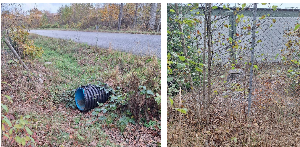
Figur 4. Trumma under Transportvägen, norr om inlopp till bef dagvattenledning, samt brunn på södra sidan av vägen
