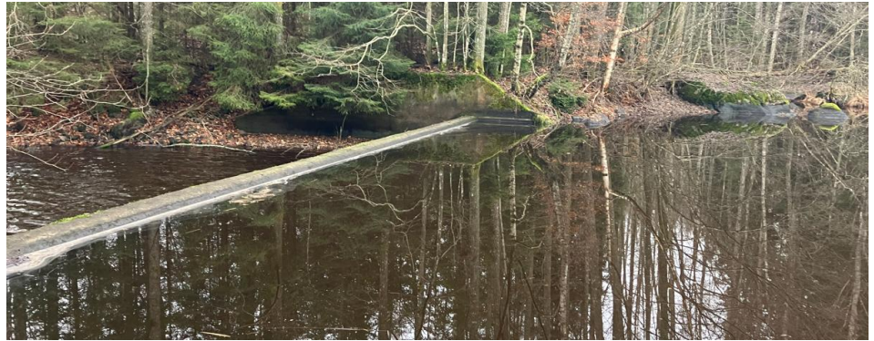
Figur 4. Befintligt betongdämme - foto taget från uppströmssidan.
