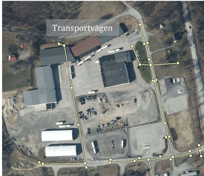
Dagvattenledningar inom fastigheten
