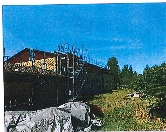
Byte av tak Dackegatan 5-9 i Väckelsång
