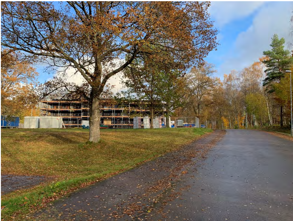
Urshults nya gymnastikbyggnad under uppförande
