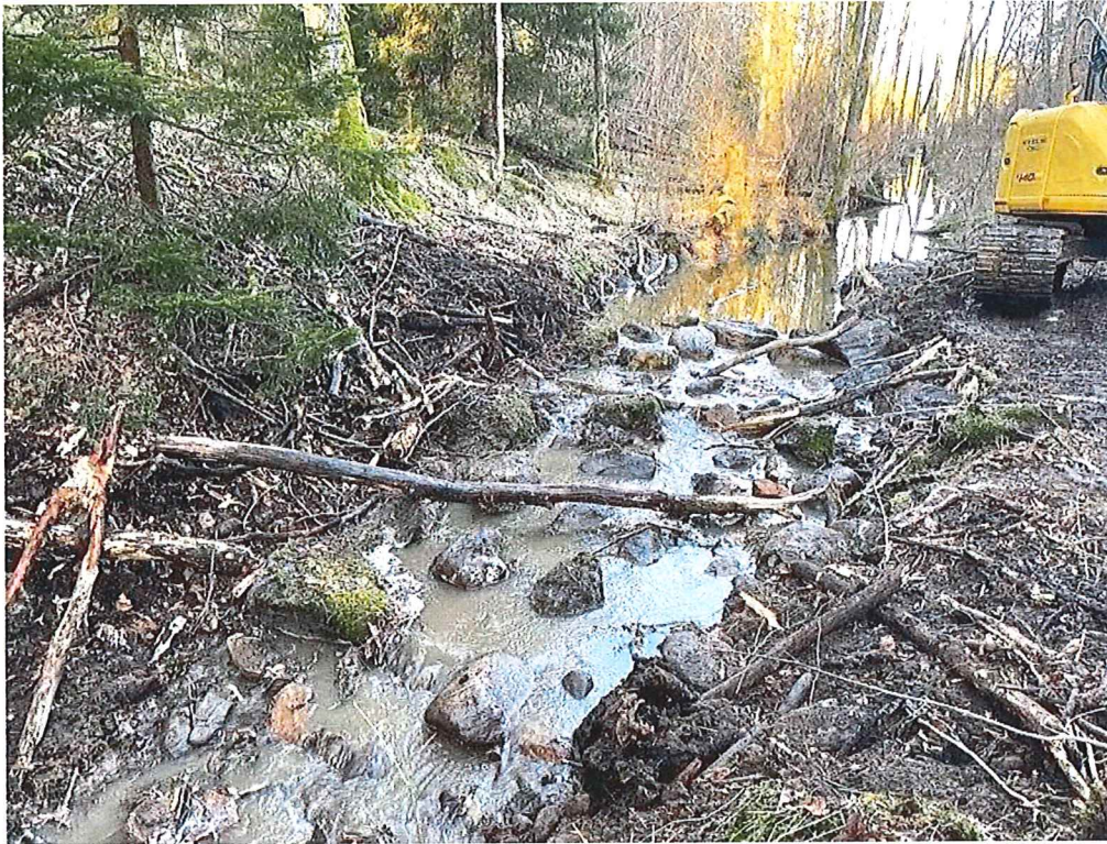
Figur 22. Igenfyllt dike som nu har blivit en bestämmande sektion. Endast uppresnat material har använts. Vattennivån uppströms är höjd med närmare en meter. Notera att den strömmande sträckan ser mycket naturlig ut vilket ger ytterligare mervärde för till exempel biologisk mångfald.
